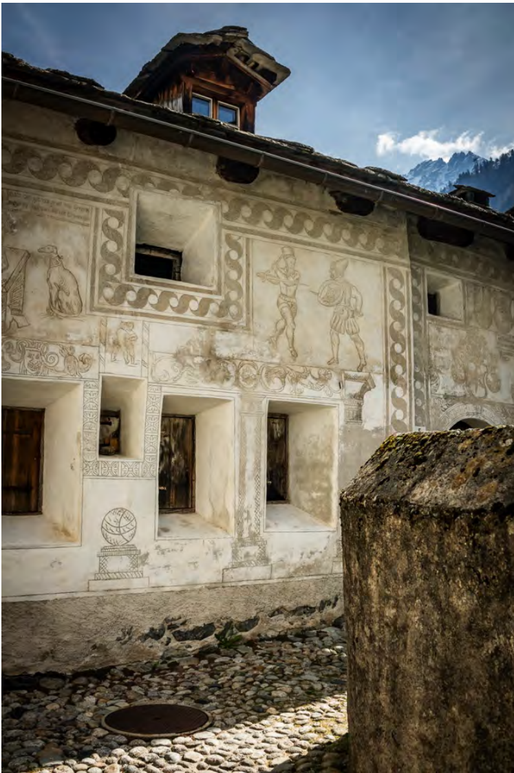
Die Fassade des Ca d'Prüz aus dem 16. Jahrhundert. Das Haus steht schon lange leer.
